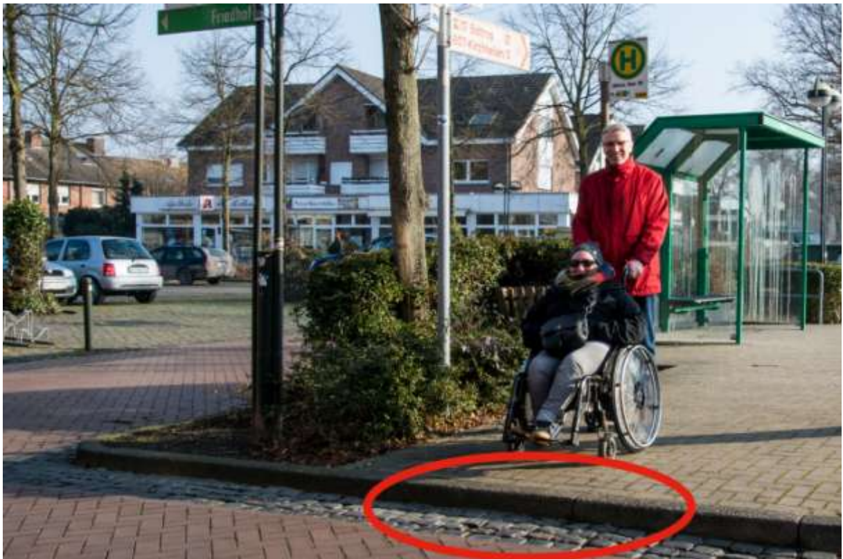
fehlende Absenkung Bushaltestelle Rathaus
